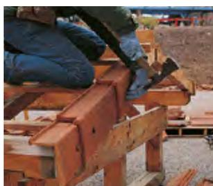
**2** Toutes les rives doivent être fixées. Un trou de clouage non débouchant permet de les fixer sur la planche de rive. Un deuxième trou de clouage sur le dessus permet de clouer sur le liteau.
