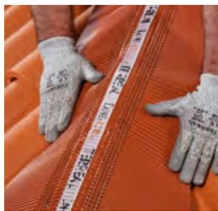
**7** Plier le closoir LAHE-ROLL sur les tuiles en se servant des plis préformés et comprimer la bavette uniformément dans le courant des tuiles des 2 côtés de la rehausse. Veiller à ne pas trop presser la partie centrale perforée sur la rehausse afin de ne pas diminuer la capacité de ventilation.
