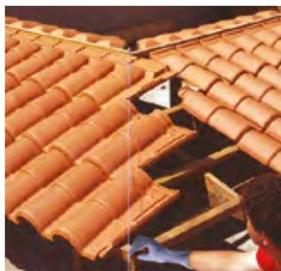
**1** Mettre en place les tuiles du premier versant au delà de l'axe de l'arêtier. Tracer au cordex le trançhis, à 3 cm en retrait de l'axe de l'arêtier.
