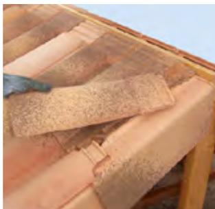
**2** La finition en rive s'effectue à l'aide de la sous-faîtière rive droite ou de double de rive sous-faîtière en fonction des modèles de tuiles. Il convient de fixer cet accessoire avec du mastic élastomère ou par vissage/clouage.
