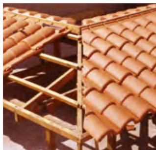
**2** Tronçonner les tuiles suivant cette ligne. Les déposer et les mettre en réserve (il est conseillé de les numérotter pour les identifier plus facilement pour la repose).
