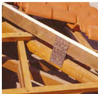
**3** Clouer la lisse de réhausse dans l'axe de l'arêtier. Il est possible de compléter la fixation à l'aide de supports galvanisés à jambes réglables.
