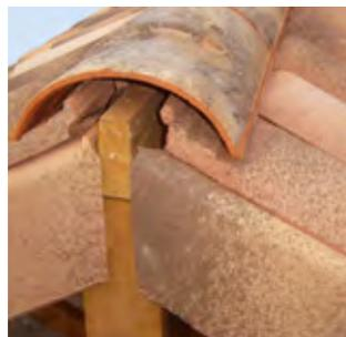
**3** Les faîtières à emboîtement sont ensuite posées et fixées sur la lisse de faîtage. Un fronton dédié au type de rives utilisées viendra terminer l'ouvrage.
