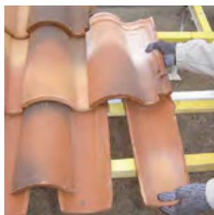
**2** Généralement les courants du système sont installés en même temps que la première rangée de tuiles : une tuile entière est posée au rang supérieur, puis le courant est mis en place.
