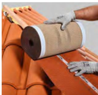
**5** Démarrer la pose du closoir souple Lahe-Roll par l'extrémité basse de la lisse d'arêtier (pour le faîtage, commencer par l'extrémité opposé au sens des vents dominants). Bien centrer le closoir sur la lisse, dernier rang de tuiles doit se trouver à une distance de 1 cm de la lisse ou bois de rehausse.
