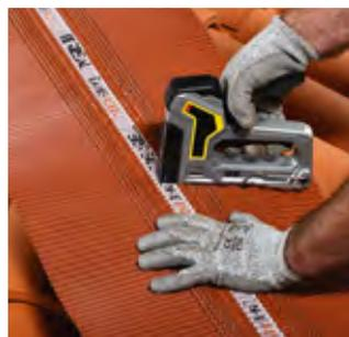
**6** Le recouvrement entre chaque closoir Lahe-Roll doit être de 5 cm. Fixer les closoirs Lahe-Roll tous les 30 cm au moyen d'agrafes ou de clous..
