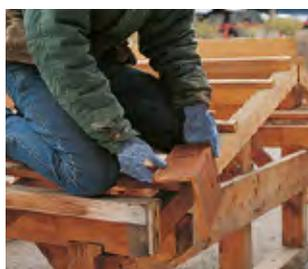
**1** Une cale à l'éégout, de l'épaisseur d'une rive, permet d'aligner correctement la première rive.
