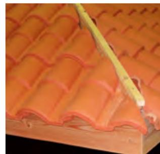
**4** Remettre les tuiles tronçonnées repérées à l'étape 2. Fixer au mastic élastomère les tuiles ayant perdu un tenon. S'assurer que les tuiles coupées soient orientées dans le sens de la pente pour ne pas guider l'eau vers l'arêtier.
