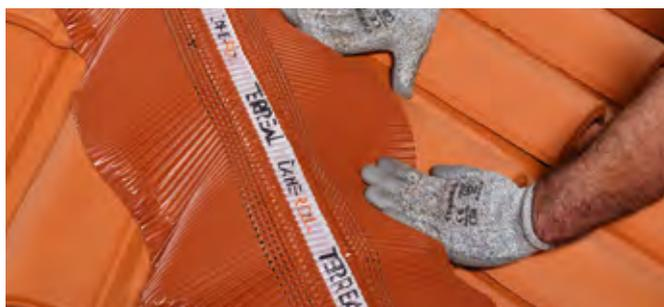
**9** Maroufler manuellement les bavettes du closoir Lahe-Roll, du sommet du galbe de la tuile (couvert) vers le creux des tuiles (courant). Bien presser les bandes adhésives contre les tuiles. En cas de fort galbe, étirer la bavette avant de maroufler afin d'obtenir l'adaptabilité maximum du closoir. Le butyle doit être en contact avec la tuile sur toute sa longueur et toute sa largeur. Les bavettes doivent recouvrir la tuile de 10 cm (ou 8 cm en creux d'onde pour les tuiles galbées).
