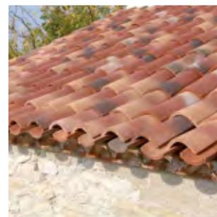
**6** Le Système Canal Sous tuile restitue ainsi l'esthétique des tuiles Canal jusqu'à l'égout, tout en offrant l'économie d'un toit en tuile DC12, DCL, DCL aspect Vieux Pays et Héritage Canal.
