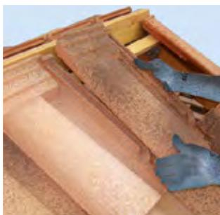
**1** La pose de la sous-faîtière s'effectue aussi simplement que celle de la tuile (pas de liteau de réhausse). Prévoir 6 à 8 cm entre l'axe du faîtage et le dernier liteau.
